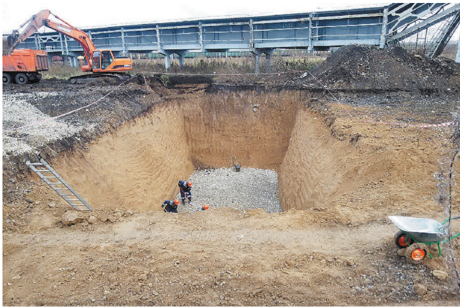
Очистные сооружения строятся на основной промплощадке Бачатского угольного разреза
