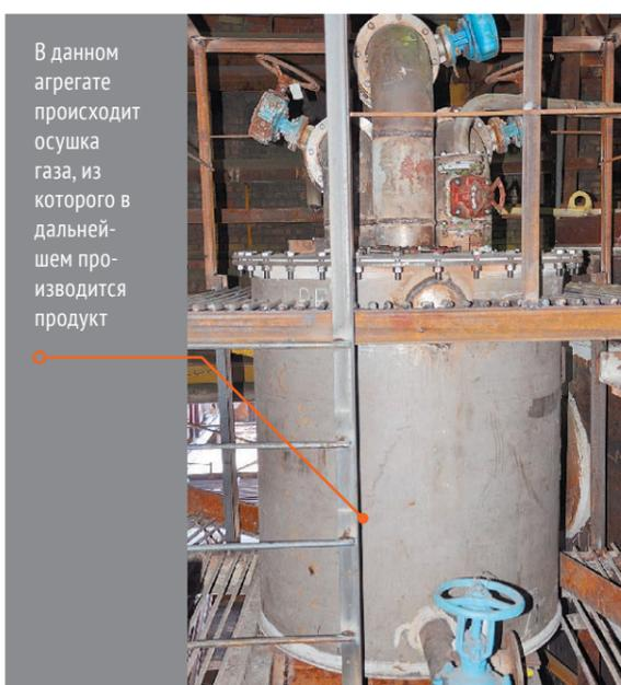
В данном агрегате происходит осушка газа, из которого в дальнейшем производится продукт
